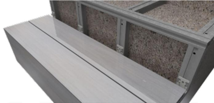
Colocados los clips, insertamos la tabla, la cual debe ser recortada para respetar el tamaño del manperlán.
