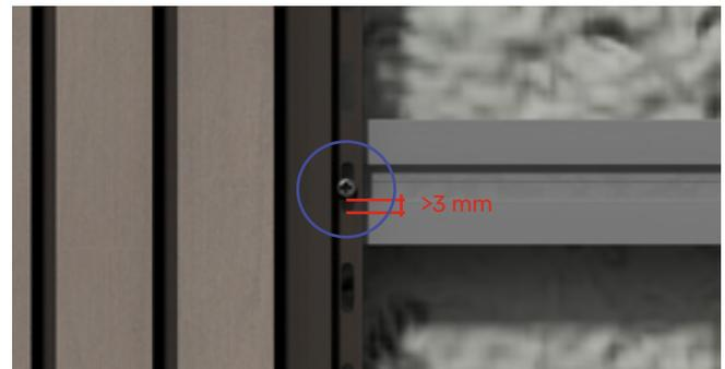
El tornillo central o más centrado, se fijará perforando la aleta del modo que se muestra en la siguiente imagen.
