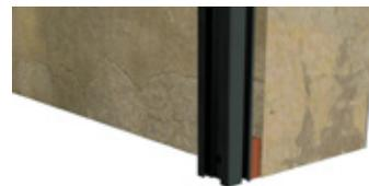
En el ejemplo mostrado, los rastreles de la instalación, se fijan al sustrato mediante tornillo-taco de golpeo de al menos 6 mm. Estos tornillos deben ser de acero inoxidable AISI 304, y AISI 316 si se la instalación se realizara en ambientes marinos.
