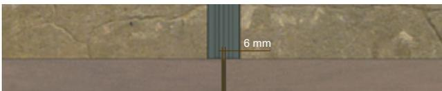
Si durante la colocación de las tablas, tuviéramos que rectificar la posición de alguna de ellas, no lo haremos golpeando directamente sobre la lama del perfil, sino que colocaremos un taco de madera en el extremo del perfil y golpearemos con la maza de nylon sobre el taco hasta conseguir la posición que buscamos tal y como se muestra en la imagen siguiente.
